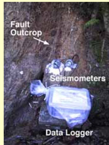
断層破砕帯に設置された地震計とデータ収録装置 A photo of seismometers and a data logger settled in a fault fractured zone.
